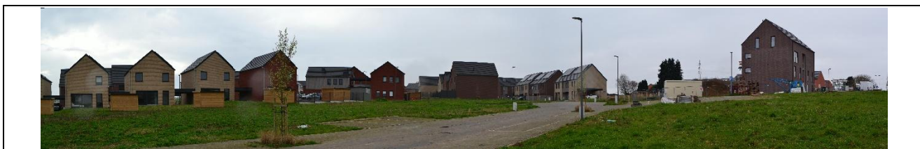
Figure 12 : Panorama 1 depuis Nivelles, rue des Marcotes (CSD, 2026).
