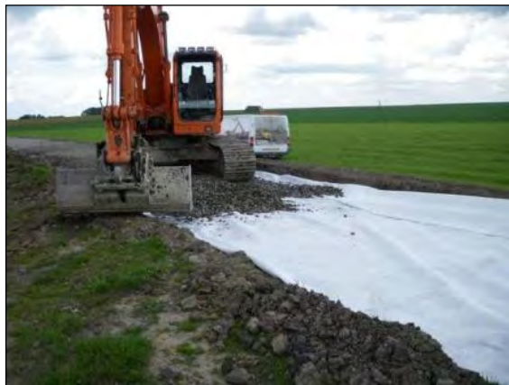
Figure 12 : Exemple de travaux d'aménagement de chemins d'accès (source : Ventis, parcs éoliens de Quévy, 2009).
