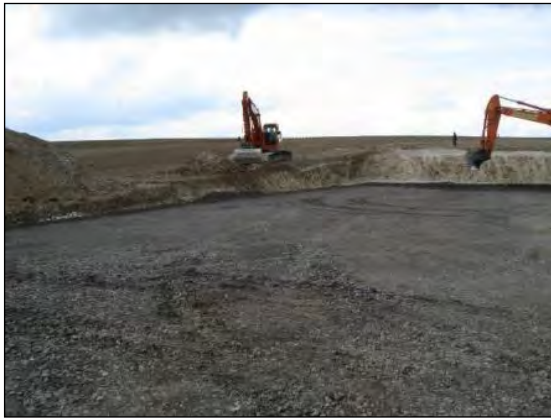
Figure 13 : Aire de montage au pied d'une éolienne (source : Ventis, parcs éoliens de Quévry et de Nivelles, 2009 et 2016).
