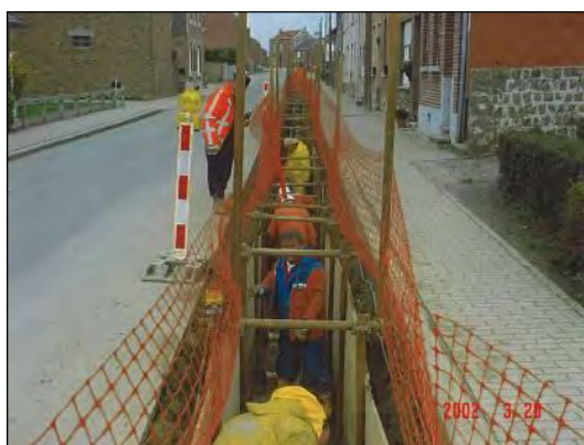
Figure 10 : Tranchées en accotements (source : Elia, CSD).
