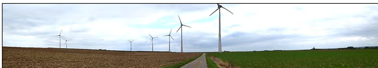
Vue depuis le site en direction de l'est. Les sept éoliennes existantes du parc de TAB 1 s'alignent dans le champ de vision, ouvert sur la vaste plaine agricole. Source : CSD, 2025
