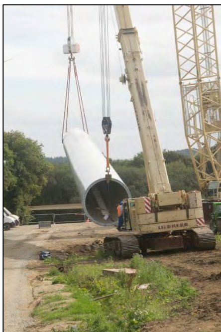
Figure 16 : Différentes étapes du montage d'une éolienne (source : L'écho, Parc éolien de Plésidy (France), 2020).
