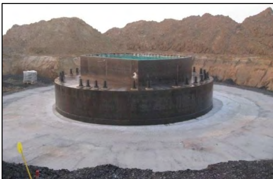
Figure 15 : Différents stades d'exécution d'une fondation circulaire (source : Ventis, 2010).
