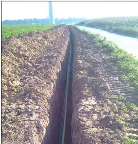
Figure 14 : Travaux de pose de câbles de raccordement (source : Ventis, 2010).
